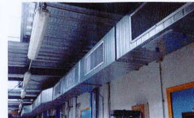
L'air rejeté à l'extérieur doit être remplacé par l'introduction d'une quantité équivalente d'air de l'extérieur.
